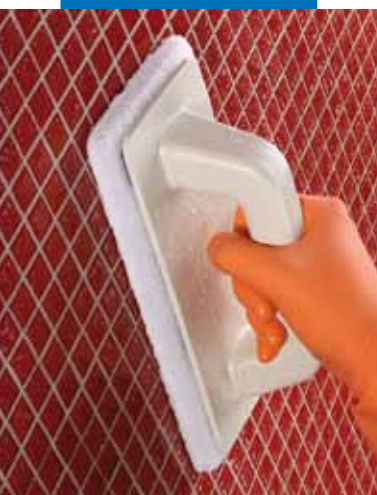
Čištění skleněné mozaiky pomocí Scotch-Brite®
