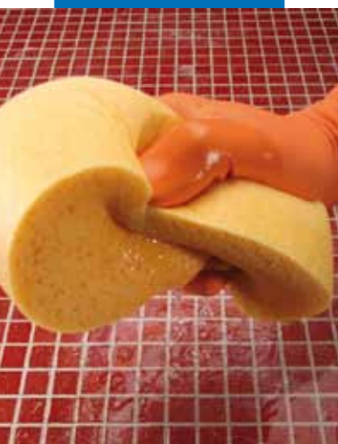
Namocení zaspárovaného povrchu před jeho dočištěním
