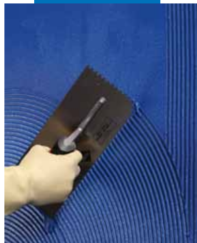
Nanášení Kerapoxy Designu v tmavé modré barvě jako lepidla pomocí zubové stěrky
